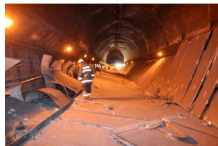
日本・中央自動車道笹子トンネル天井崩落事故 (2012.12.2, 供用37年)
